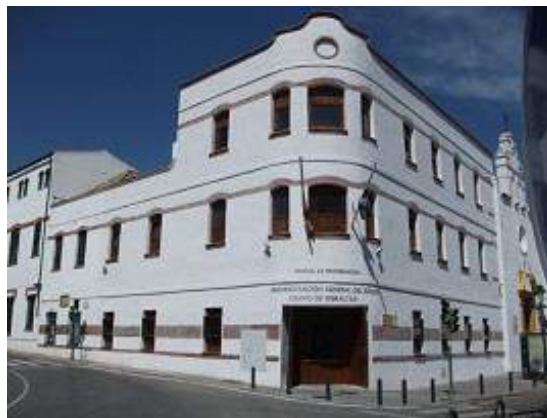
Sede de la Oficina Coordinadora de la Administración General del Estado en Campo de Gibraltar
